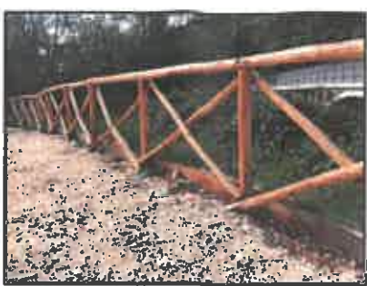
Recinzione tipo 2 Recinzione con pali in castagno
